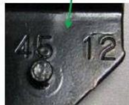
Prägung des Herstelldatums der Grundplatte -> KW45/ 2012
