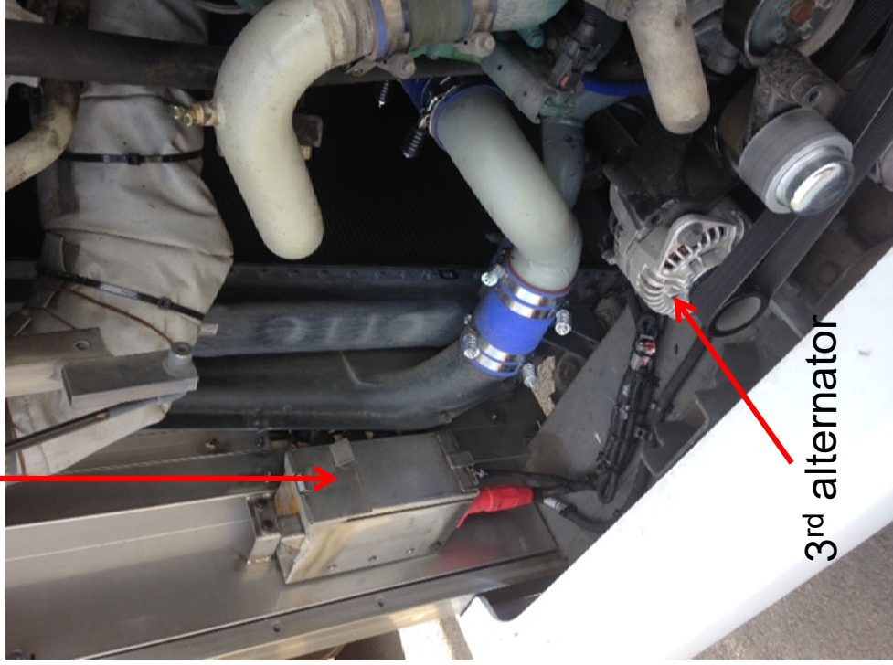
Fan power BOX
